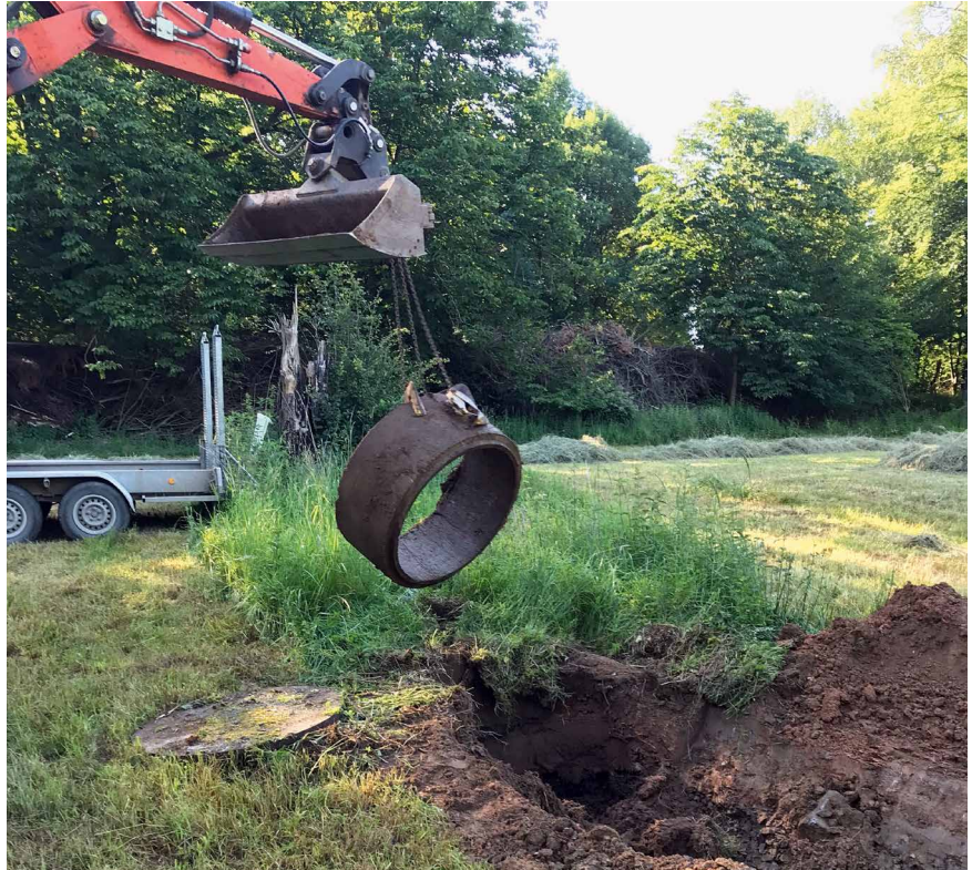
Der Bagger entnimmt die Quelfassung
