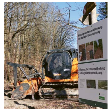
Mulchraupe bei der Feinerschließung nach vorangegangener digitaler Planung
