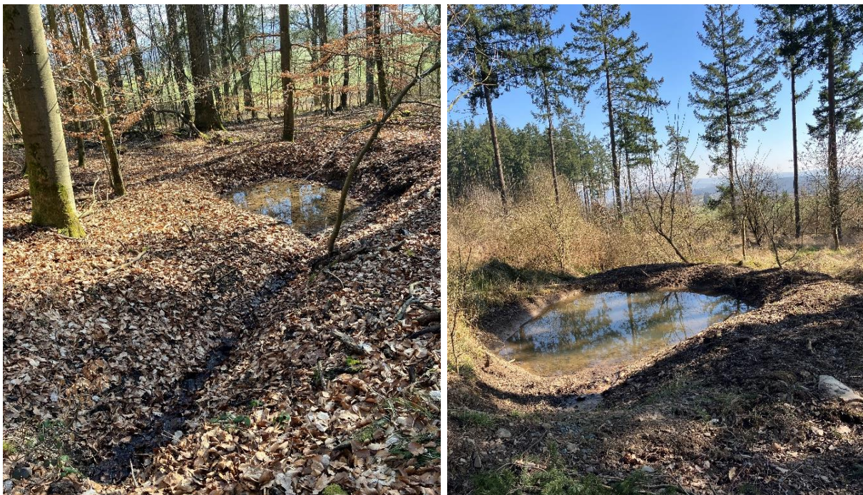
Abbildung 5: Wasserretentionsbecken Revier Lohra, Wasserführung vom Wegekörper in den Wald
