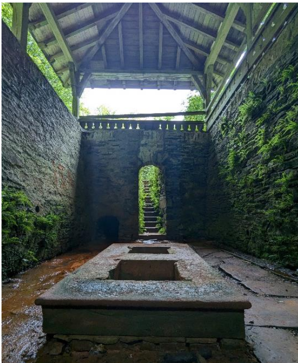
Abbildung 18: Der Werkerbrunnen am Sauerbornbach ist eine der wenigen verbauten Quellen im Staatswald
