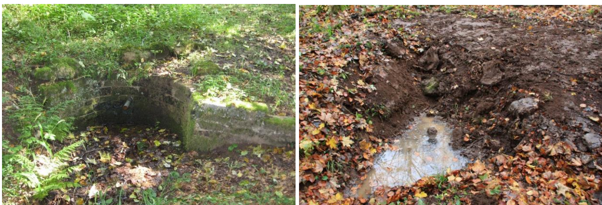
Abbildung 5: Saubornquelle vor (links) und nach (rechts) der Renaturierungsmaßnahme
